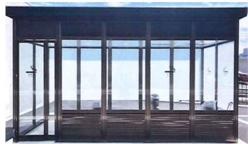
人吉市の新庁舎に新設された喫煙場所(正面・近景)
