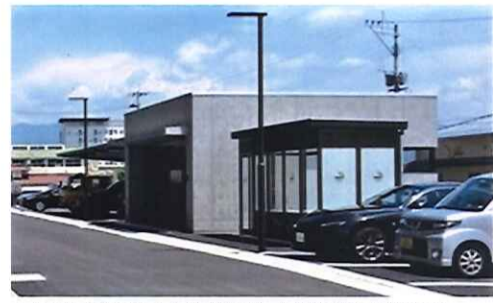
人吉市の新庁舎に新設された喫煙場所(遠景)
