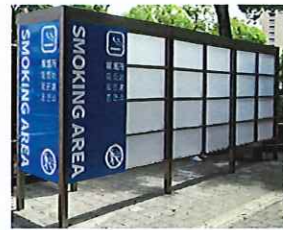
改装・移設されたパーティション設置のJR鳥取駅北口の喫煙所
